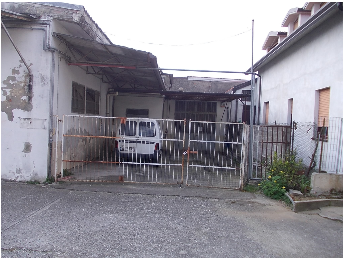
VISTA NORD CAPANNONE IN ADERENZA
