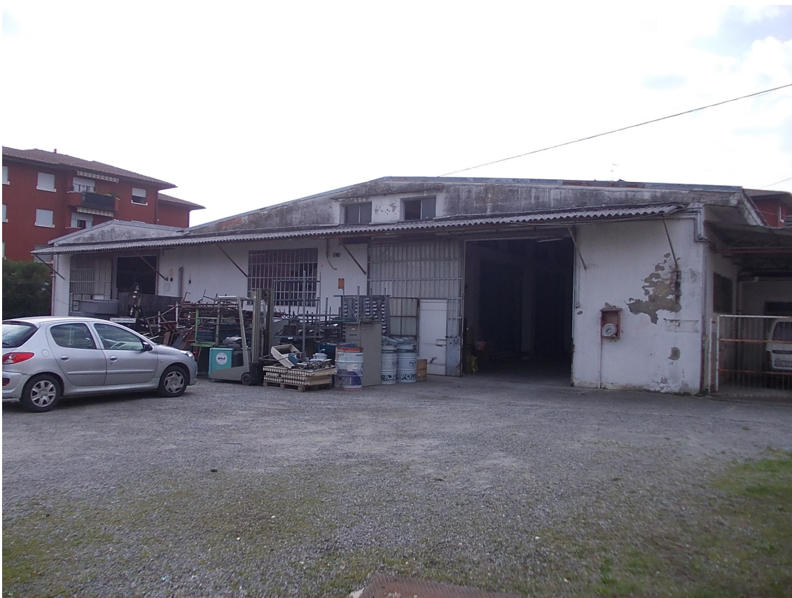
VISTA NORD CAPANNONE
