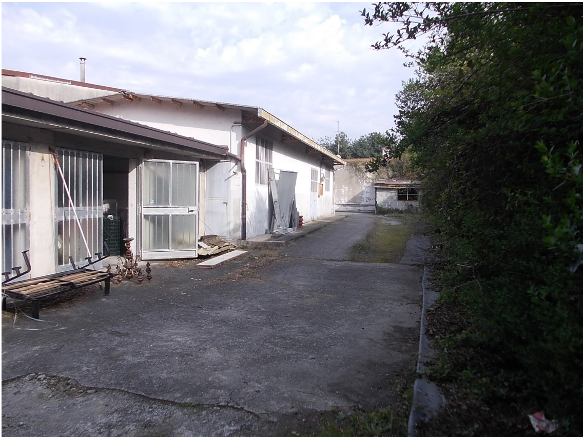
VISTA EST CAPANNONE
